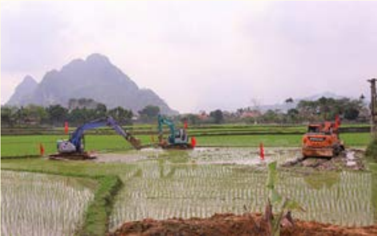
Các nhà thầu tiến hành thi công
